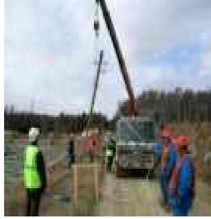
Resim 1.11: Vinç yardımıyla direk dikimi
