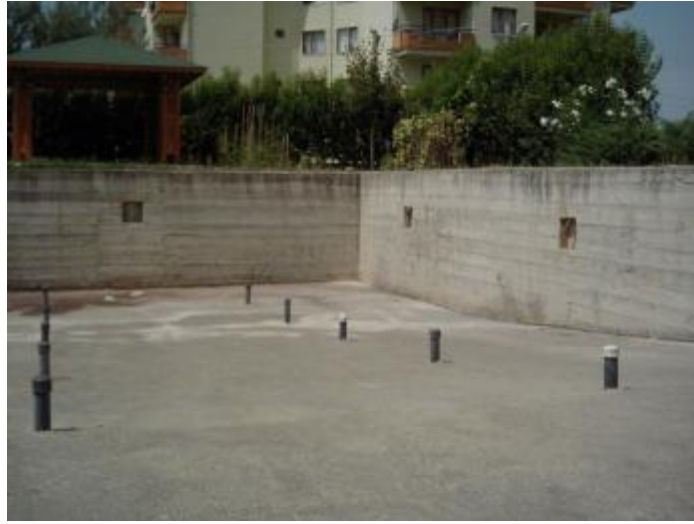
Resim 5.8: Havuz betonarmesi içinde bırakılmış aydınlatma elemanı boşlukları
