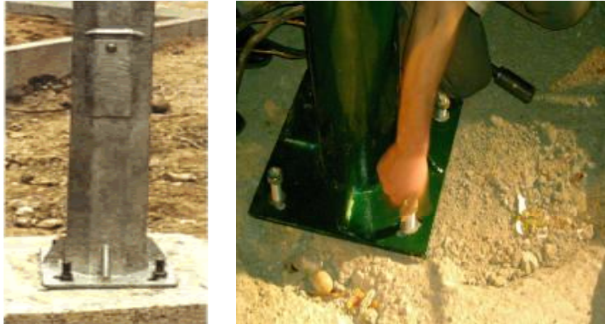
Resim 1.12: Galvaniz ve konik aydınlatma direk temelleri
