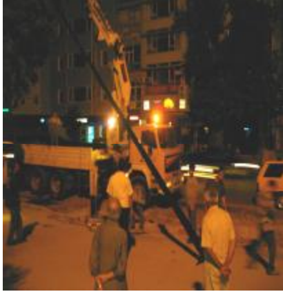
Resim 1.11: Vinç yardımıyla direk dikimi
