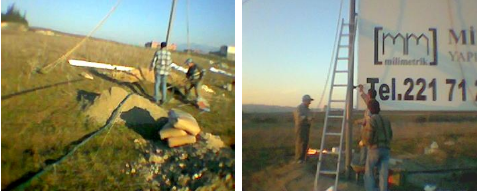
Resim 4.6: Reklam panosu kablo çekimi işlemi
