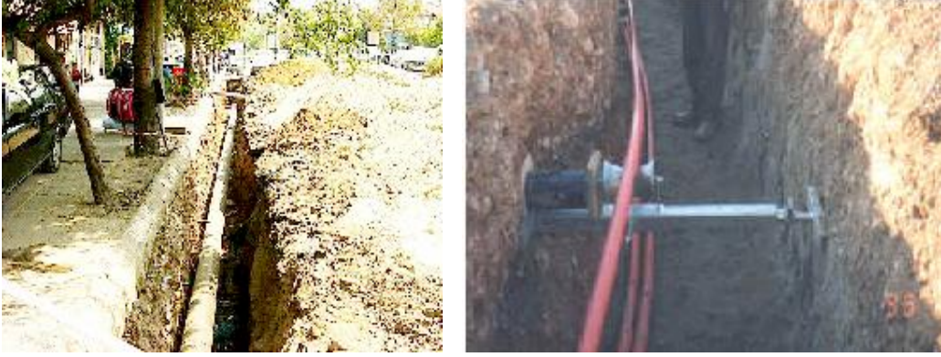
Resim 1.10: Enerji hatları için açılmış kanallar
