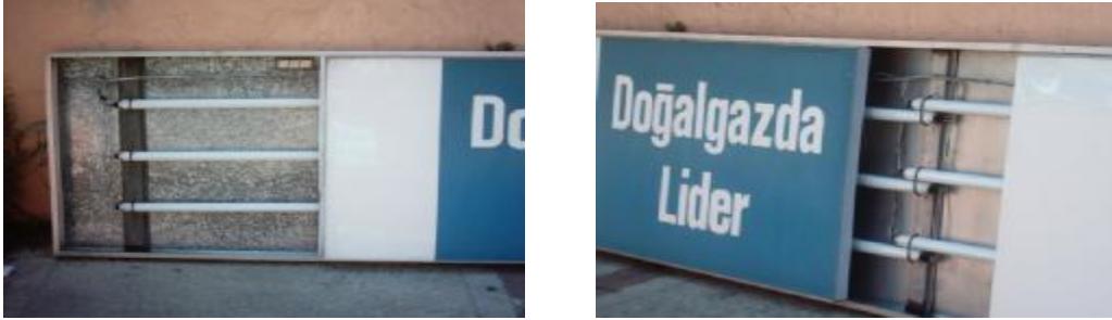
Resim 4.2: Floresan tip sistem reklam aydınlatmasında bağlantıların yapılması
